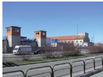
Potabilizadora de San Isidro.
