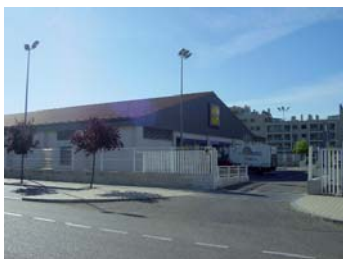
Almacén mayorista y supermercado en la calle Teide.
