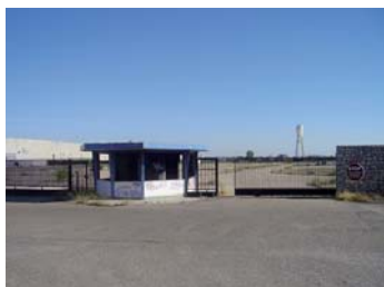
Imágenes de la antigua fábrica de Uralita, actualmente en estado de abandono.
