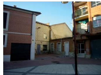
Vivienda en ruinas en la plaza de las Siete Partidas.
