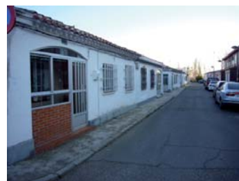
Casas molineras de promoción oficial en la calle Palacio.
