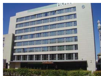
Hotel situado en el Paseo de Zorrilla.
