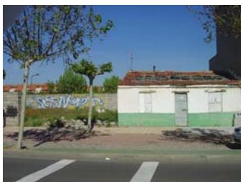
Vivienda molinera abandonada junto a un solar correspondiente a otra ya desaparecida en la Cañada Real.
