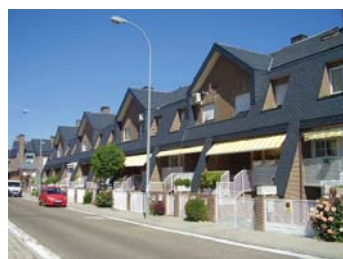
Conjunto de chalets adosados en la calle Manuel Mucientes.
