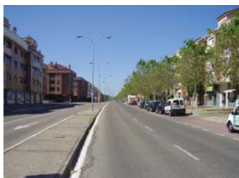
Carretera de Rueda a su paso por el barrio de Parque Alameda.
