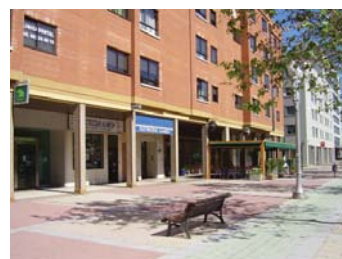
Soportales comerciales a lo largo del Paseo de Zorrilla.
