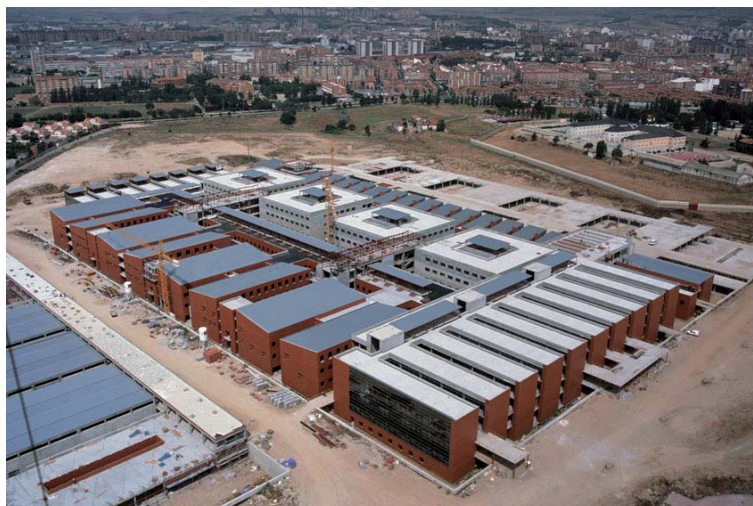
El nuevo hospital Río Hortega ha sido el gran impulsor para la ocupación de toda la zona. En la imagen, un momento de su construcción.
