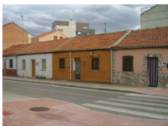
Casas molineras en el asentamiento de la Bombilla.
