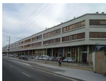
Edificio de oficinas en el extremo norte del barrio.
