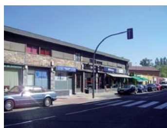
Edificio de locales comerciales al inicio del Camino Viejo de Simancas.
