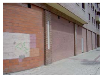
Locales comerciales cerrados en una de las promociones de vivienda colectiva.
