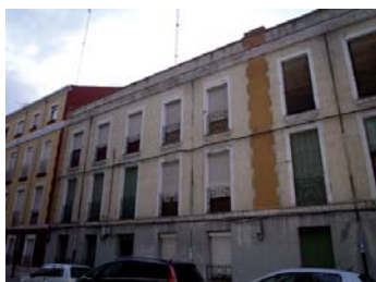
Edificio en la calle de Alemania, con un cierto deterioro.
