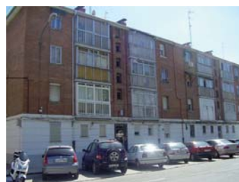
Los polígonos oficiales se caracterizan por la ausencia de espacios comerciales.
