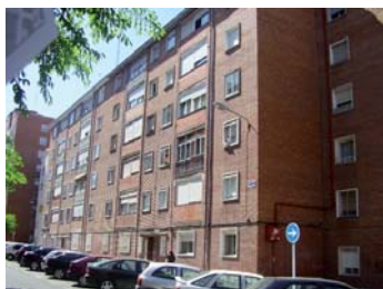
Bloque del polígono Dieciocho de Julio sin rehabilitar.
