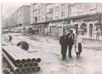
Calle Soto durante las obras de urbanización en el año 1990.
