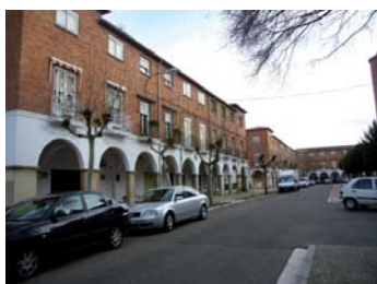
Bloques de vivienda colectiva en la plaza Porticada.
