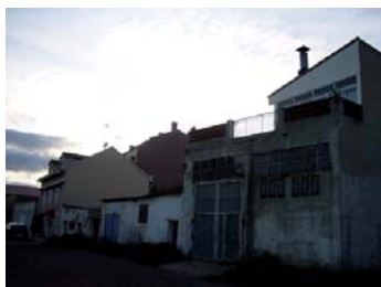
Grupo de edificios muy deteriorados.
