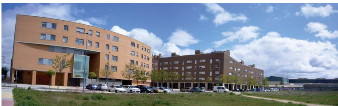
Bloques de viviendas en Plan Parcial El Pato.
