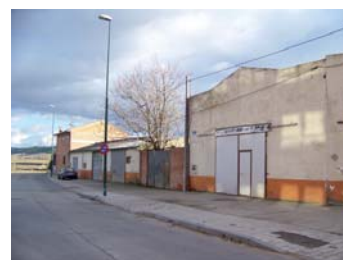
Edificios en mal estado en la calle Hornillos.
