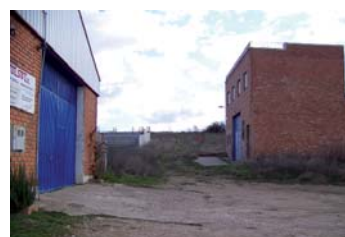
Nave industrial junto a la carretera de Villabáñez.
