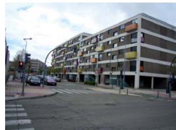
Bloque de viviendas en la calle Santa María de la Cabeza, en el plan parcial Campo de Tiro.
