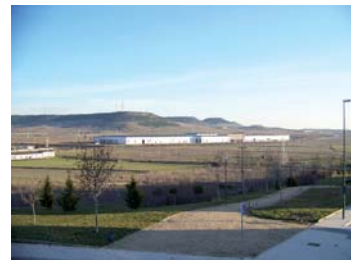
Vista de los talleres de RENFE.
