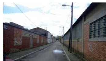
Naves y viviendas en situación de abandono en la calle Santa Eulalia.
