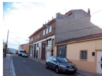
Ejemplo de la mezcla de viviendas con talleres.
