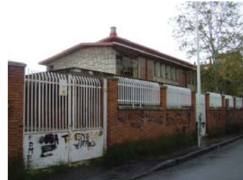
Grupo escolar abandonado en el polígono Veintinueve de Octubre.
