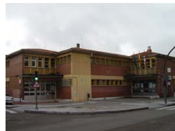
Colegio público Cristobal Colón, situado en la calle Cigüeña.
