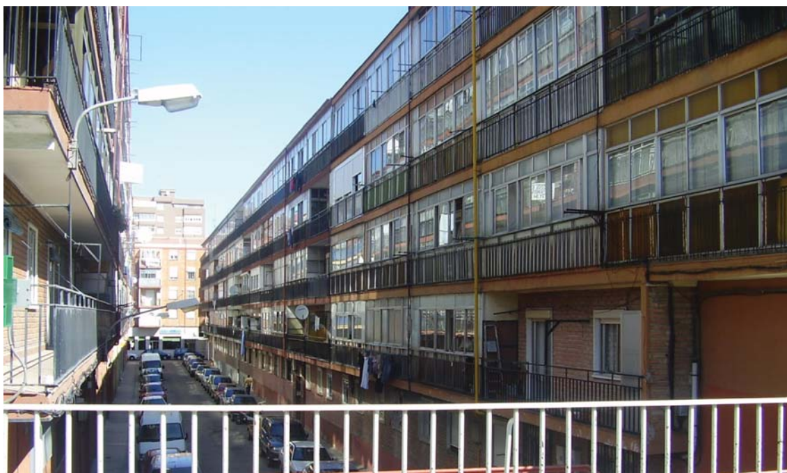
Calle del Ánade, una de las calles interiores de la gran promoción en la confluencia del paseo de San Isidro y el paseo Juan Carlos I.
