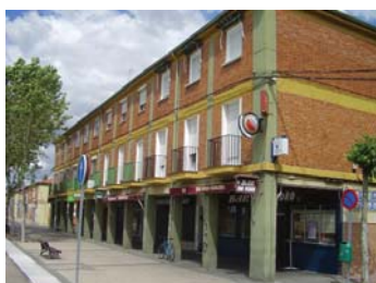
Bloques de vivienda colectiva en manzana cerrada, en la avenida de Santander.
