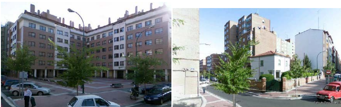
Unidad ejecutada. Normalización sin ejecutar.
