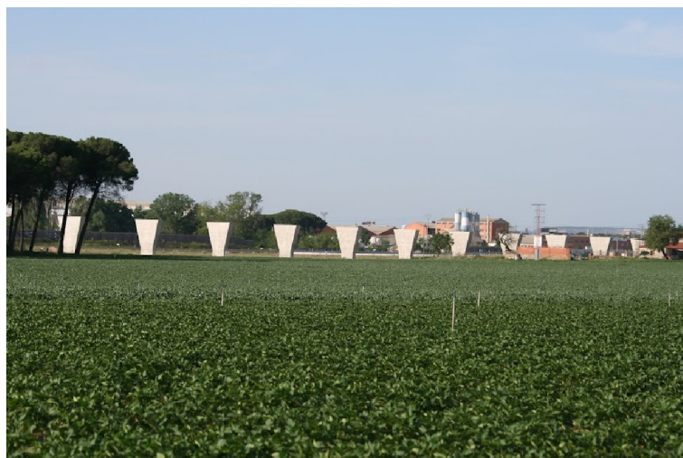
Pilares realizados para el by-pass ferroviario. Todo el esfuerzo realizado en el nuevo sistema ferroviario tiene una trascendencia urbanística evidente.
