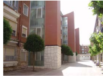
Núcleos de ascensores incorporados a los bloques.
