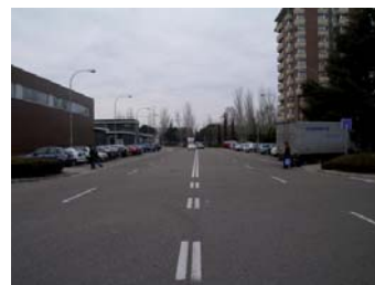
Fondo de saco sobredimensionado en el final de la calle Pío del Río Hortega.
